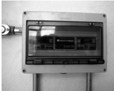
Figura 5. Módulo receptor con alarma sonora (Acutec 35 Wallace and Tiernan). Nota. Elaboración propia.
