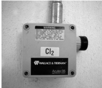
Figura 4. Sensor detector de fugas de gas cloro (Wallace and Tiernan). Nota. Elaboración propia.
