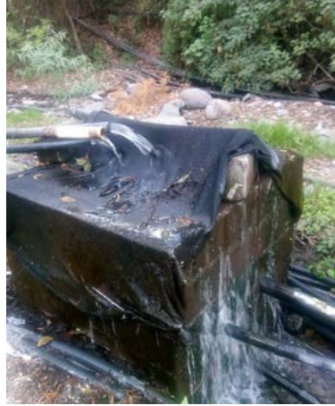
Figura 4.- Caja de concreto con conexión de mangueras. Foto de Diana Laura Yañez Reyes, 2020.
