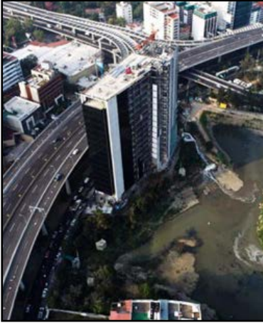
Figura 1.- Presa Anzaldo. Predio ubicado en Blvd. Adolfo Ruiz Cortines No. 3042 y presa Anzaldo. Fuente: https://jefaturadegobierno.cdmx.gob.mx/comunicacion/nota/inicia-gobierno-capitalino-demolicion-de-inmuble-en-presa-anzaldo
