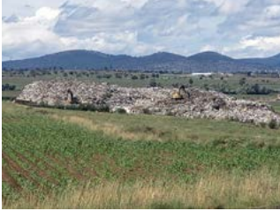
Figura 14 Relleno intermunicipal de San José Chiapa, al fondo a la derecha se aprecia el casco de la exhacienda de San Isidro Ovando. Foto: Concepción Juárez.
