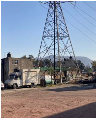
Figura 3 (izquierda).- Torre de alta tensión colindante con construcción habitacional. Foto: Valentín Pérez Cruz.
