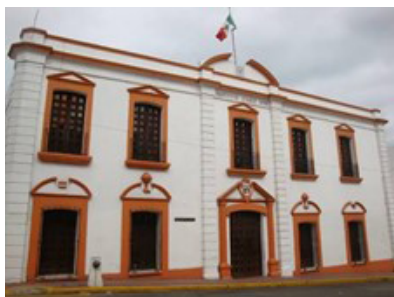
Figura 34. Fachada del Instituto Juárez en Villahermosa, Tab.
