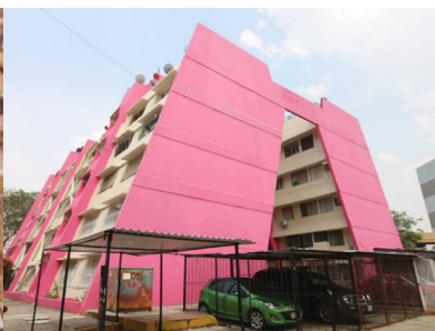
Figura 53. Fachada de un edificio en el conjunto habitacional Los Ríos, 2017.
